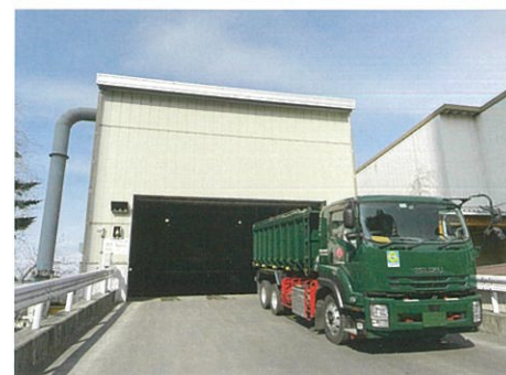
汚泥受入設備
